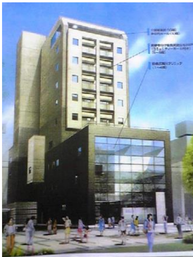
ノ・メゾン広瀬川（前橋市千代田町）
