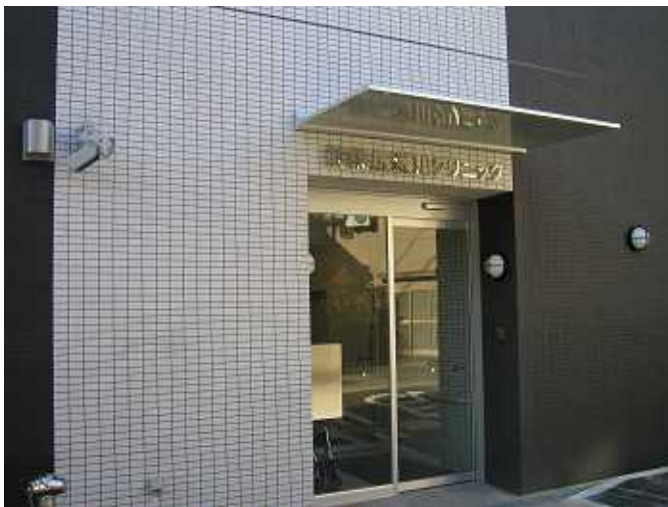
建物南側 (クリニック入口)
