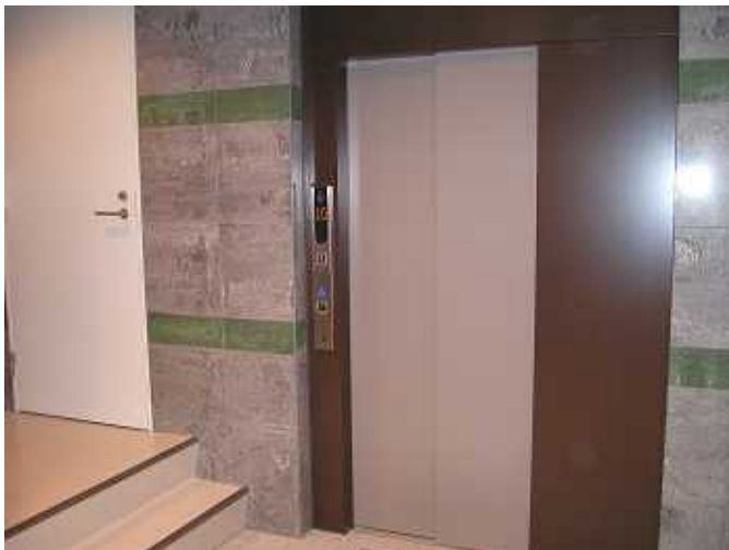
エレベーター
