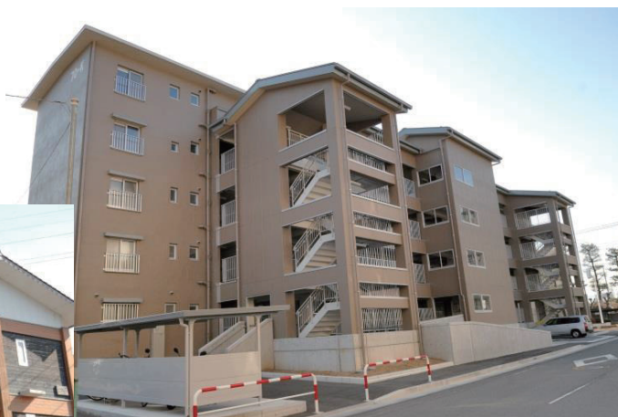
外部エレベーターを設置してバリアフリー化した 【広瀬第一県営住宅K棟】
